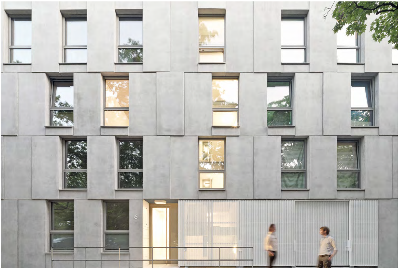
Kunst des Zusammenfügens: Die Außenwand aus kerngedämmten Betonfertigteilen ist primär tragendes Bauteil und prägnante Fassade.
